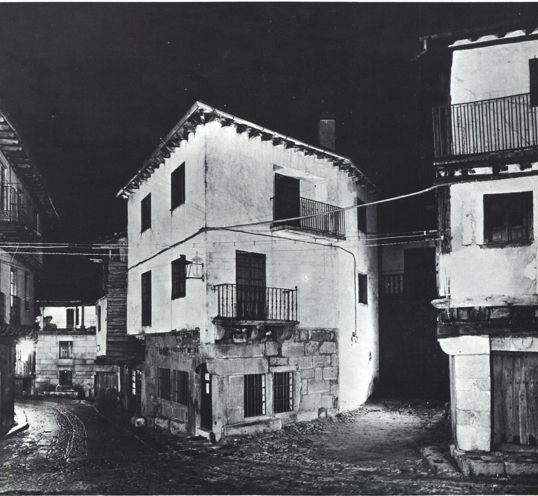
El curioso entramado de las fachadas albercanas, queda eliminado o cubierto por el enfoscado en las restauraciones o lo que es aún peor, superponiendo al enfoscado un entablado que remeda al primitivo entramado.
