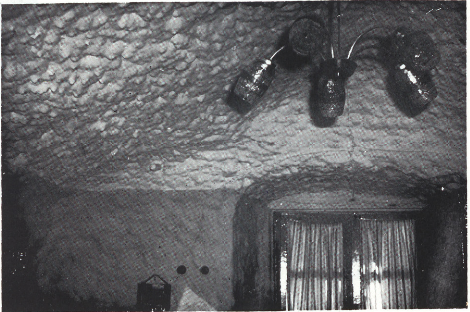
Aspecto de la excavación abovedada de los techos. Cañada de la Fifa nº 9
